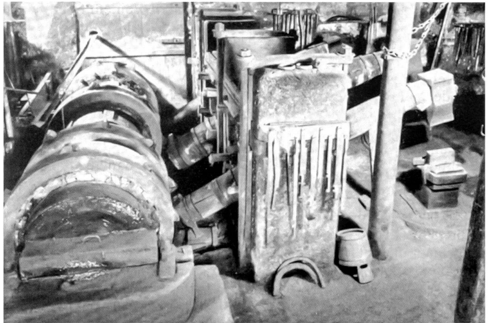
Der direkt vom Wasserrad getriebene Wellbaum mit den Nockenringen und der Hammerstuhl mit den drei Schwanzhämmer. Die letzte der ursprünglich drei Anlagen des 17. Jh.
