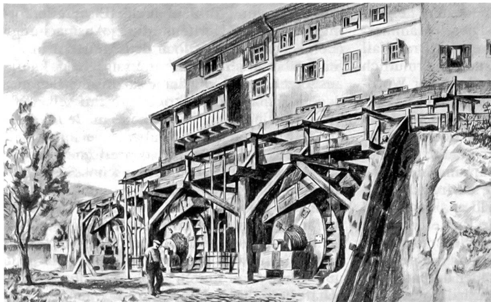
Die Hammerwerke Müller nach 1871, vor der Umstellung auf Turbinenantrieb. Rekonstruktionszeichnung von Ernesto Bocchetti, 1944.
