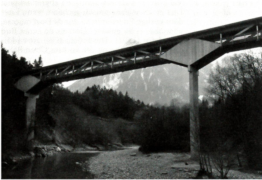
Die längste Holzbrücke der Schweiz
