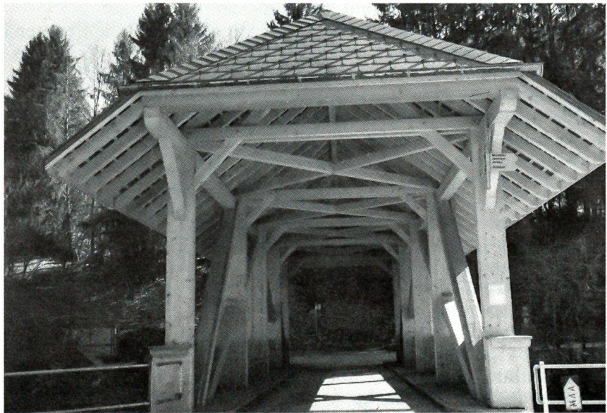
Schönheit der Zimmermannskunst Beeindruckende klare Gestaltung der neuen Holzbrücke über die Simme bei Boltigen (Photo Fritz Lörtscher, Bern)
