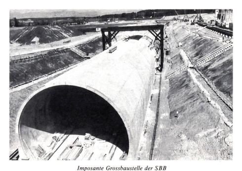
Zwischen Mattstetten und Bäriswil wird der nördliche Eingang zum sechs Kilometer langen Grauholztunnel der SBB gebaut. Ein Teilgewölbe des Tagbautunnels steht bereits in der Baugrube.
