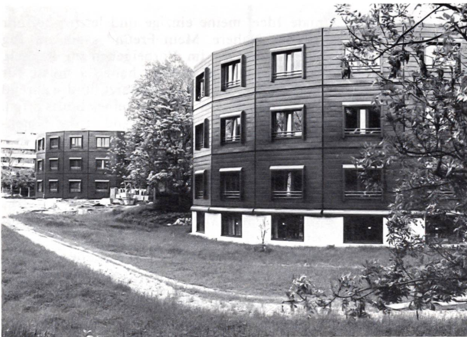
Tiefenauspital in Bern wird baulich erneuert
