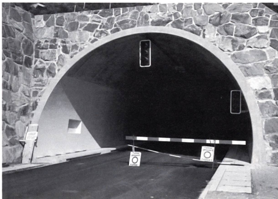
Neubauten an der Bern-Lötschberg-Simplon-Linie Für die wintersichere Zufahrt zum Autoverlad in Goppenstein wurde dieser fast 2400 Meter lange Strassentunnel Hochtenn-Mittel erbaut. Unser Bild zeigt das Südportal bei Hochtenn. Der Tunnel wurde 1987 dem Verkehr übergeben. (Photo Fritz Lörtscher, Bern)
