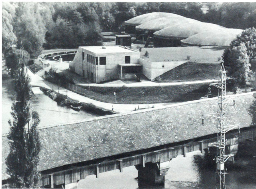
ARA Neubrücke ausgebaut
