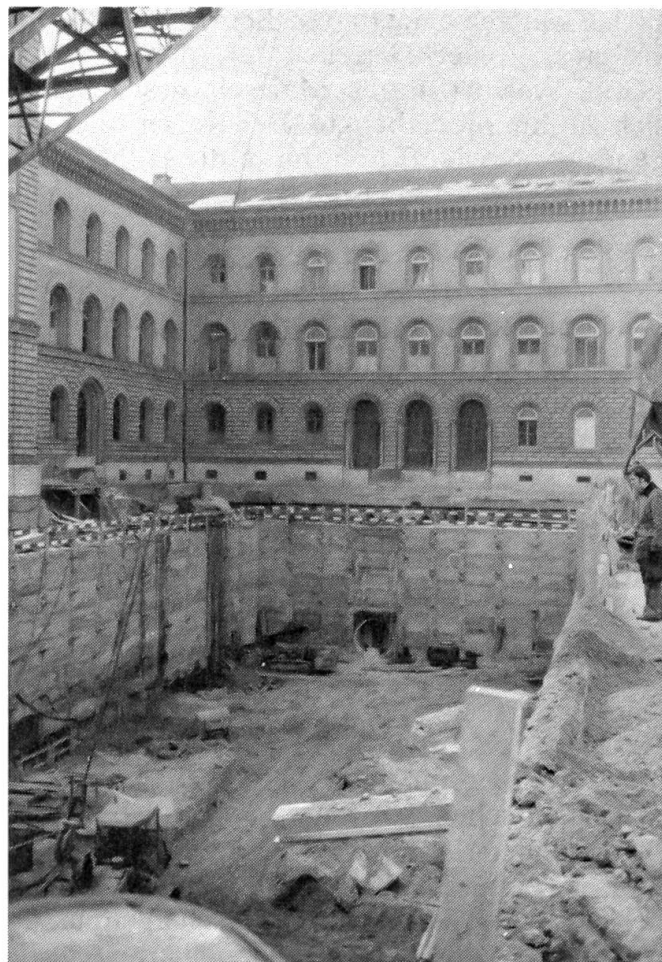
Personenschutzräume für das Bundespersonal Im Hofe des Bundeshauses-West dient diese mächtige Baugrube der Erstellung von vorgeschriebenen Schutzräumen.
