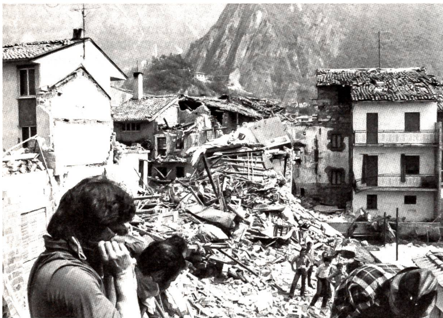
Erdbebenschäden in der norditalienischen Provinz Friaul
