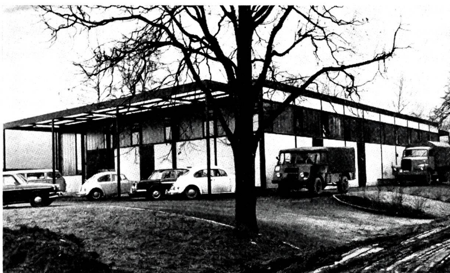
Neue Werkstätte für die kleinste Rekrutenschule der Schweiz, die Hufschmied-RS, im Sand bei Schönbühl.
