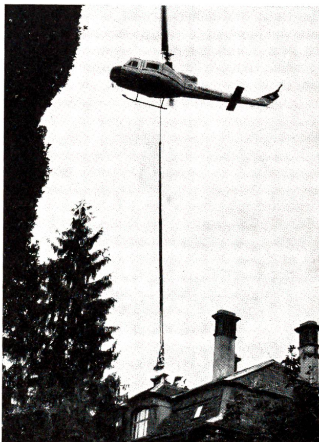
Immer mehr setzt sich der Helikopter für schwierige Transportaufgaben durch. Hier pflanzt er eine riesige Antenne auf das Verwaltungsgebäude des Touringclubs der Schweiz in Bern auf. Die Antenne dient der Funkverbindung mit den Pannenfahrzeugen des TCS.
