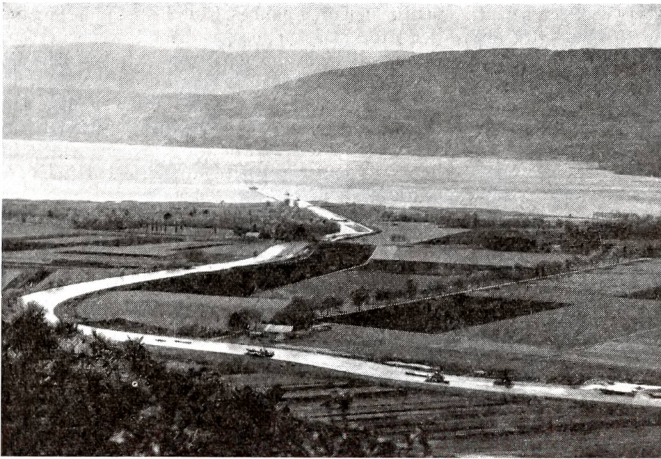
Einen wichtigen Bestandteil der zweiten Juragewässerkorrektion bildet die Verbreiterung und Vertiefung der Kanäle. Hier eine Übersicht über die Einmündung des Broyekanals in den Neuenburgersee; auf dem Kanal erkennt man im Vordergrund die Schwimmbagger, mit denen das Flußbett vertieft wird.
