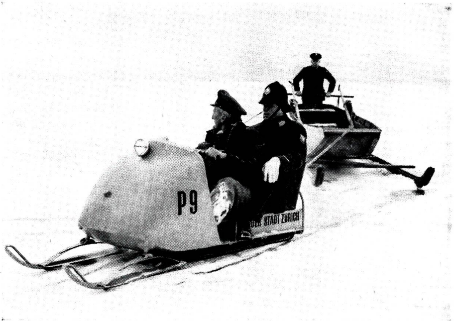
Rettungsbereite Polizei Auf dem zugefrorenen Zürichsee verwendete die Polizei diesen Raupen-Motor-schlitten mit angehängtem Rettungsboot.
