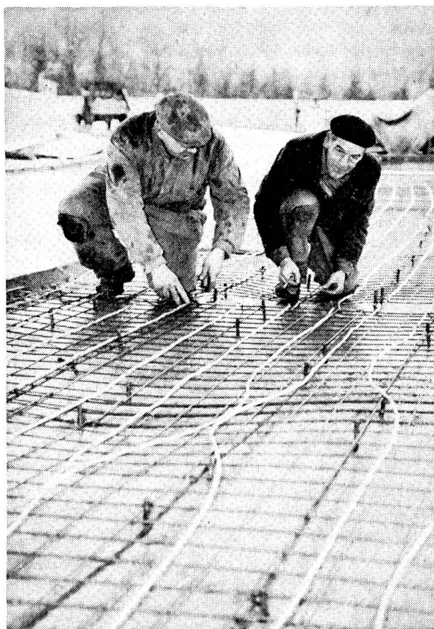
Bei Holderbank wurde eine Brücke, die stets zur Vereisung neigte, durch den Einbau einer Heizung verkehrssicher gemacht.
