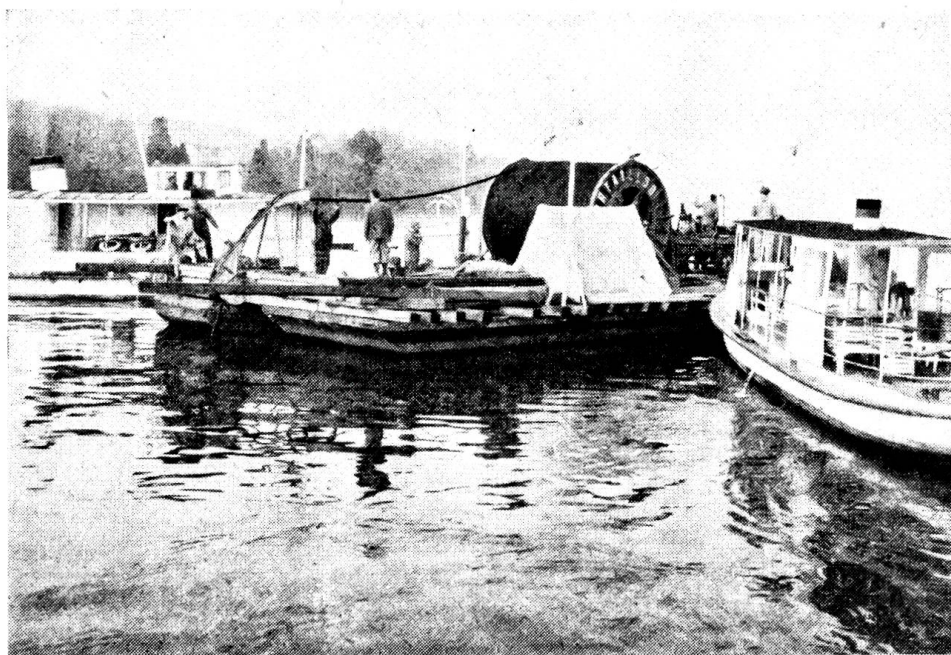
Im Februar 1962 verlegten die Bernischen Kraftwerke im Thunersee ein neues Starkstromkabel; es ist über dreieinhalb Kilometer lang und 61 Tonnen schwer. Zwei Dampfboote stoßen den Doppelponton mit der Kabelrolle.
