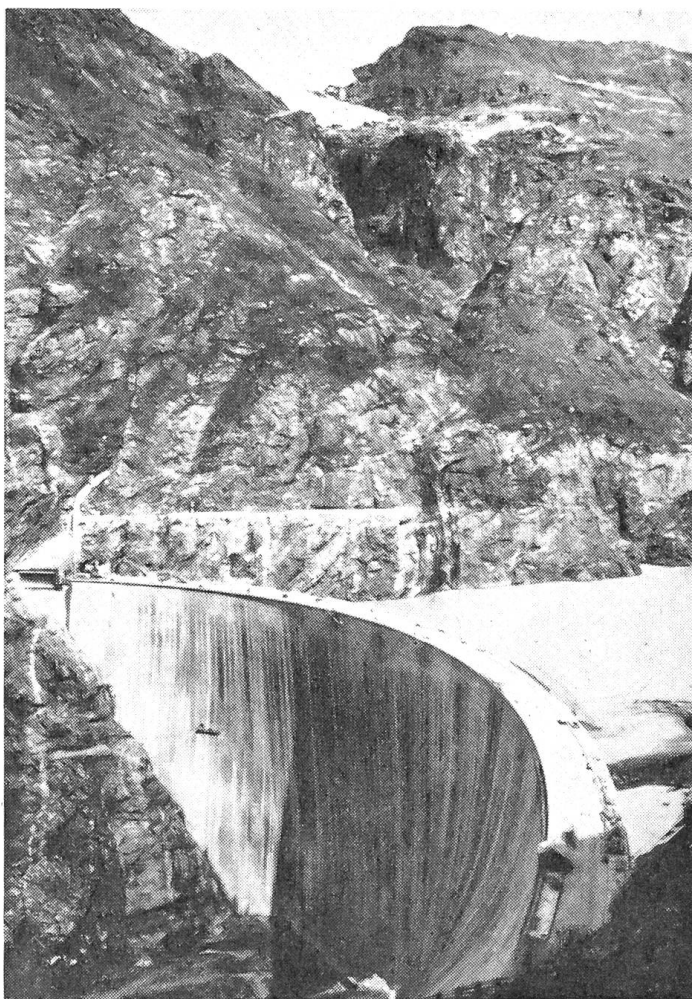
Im Herbst 1958 konnte die Mauvoisin-Staumauer eingeweiht werden. Sie ist 520 Meter lang, 237 Meter hoch und am Scheitel 14 Meter breit.
