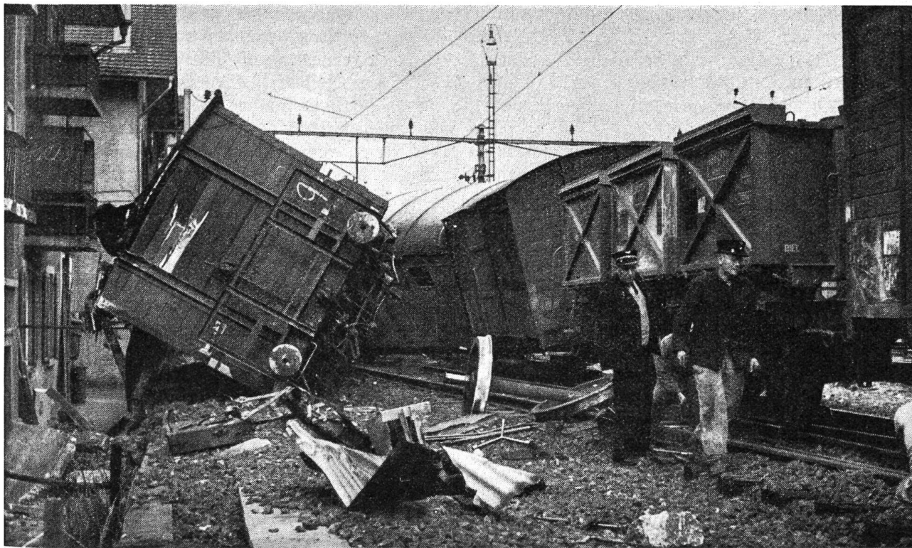
Infolge Achsenbruchs entgleisten im Bahnhof Burgdorf fünf Güterwagen. Glücklicherweise entstand nur Materialschaden.
