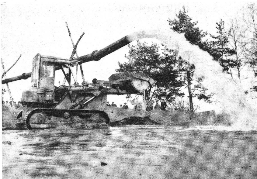
Die zunehmende Verschlammung des Murtensees wird nun endlich bekämpft. Hier die Arbeit im Broye-Delta: Der Schlamm wird auf das Land befördert, und das gereinigte Wasser läuft in den See zurück.
