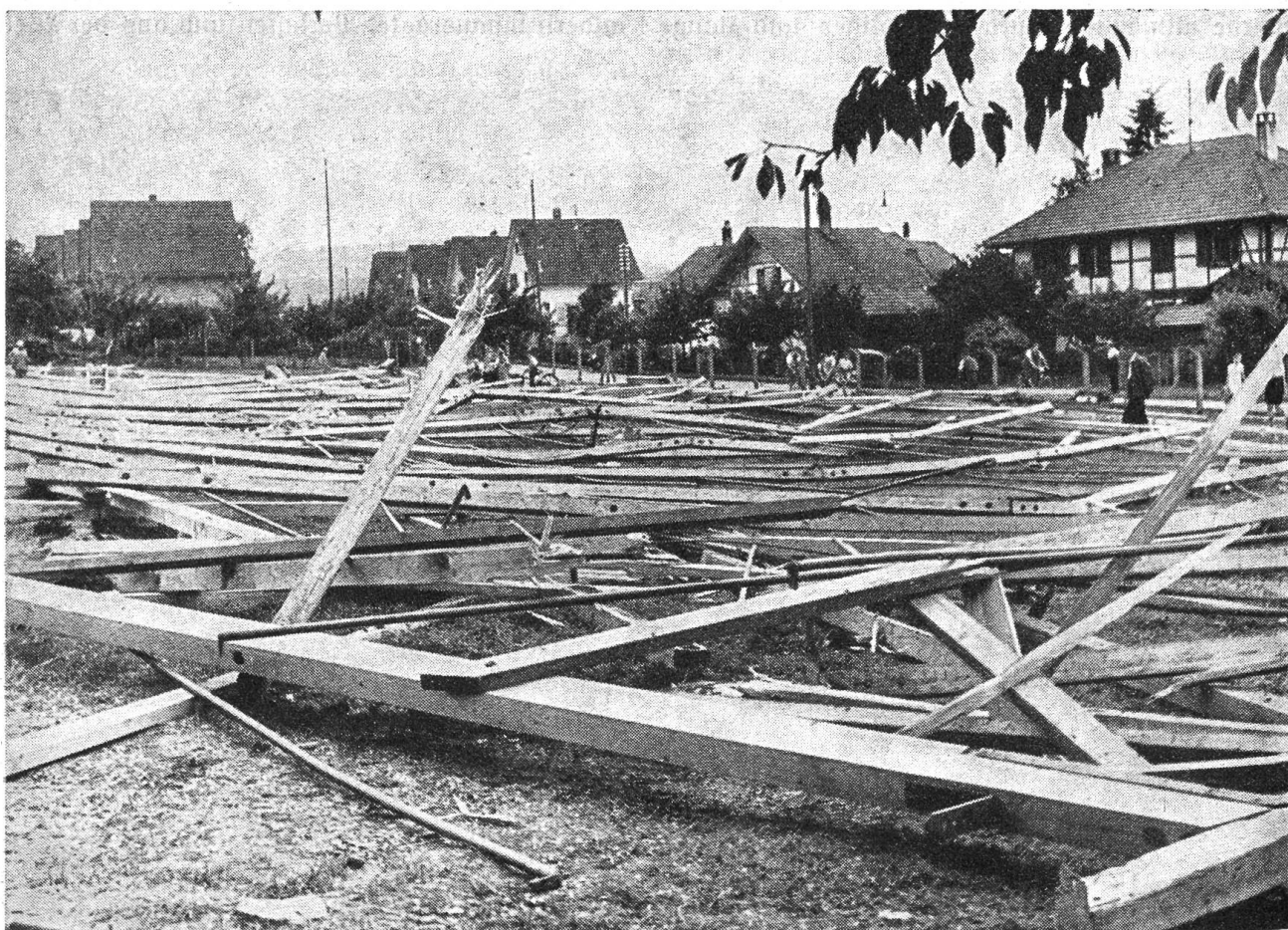
Beim Abbruch der für das kantonälbernishe Zoderfest erstellten Festhalle stürzte infolge einer falschen Manipulation an der Seilwinde die ganze 90 m lange Halle ein.
