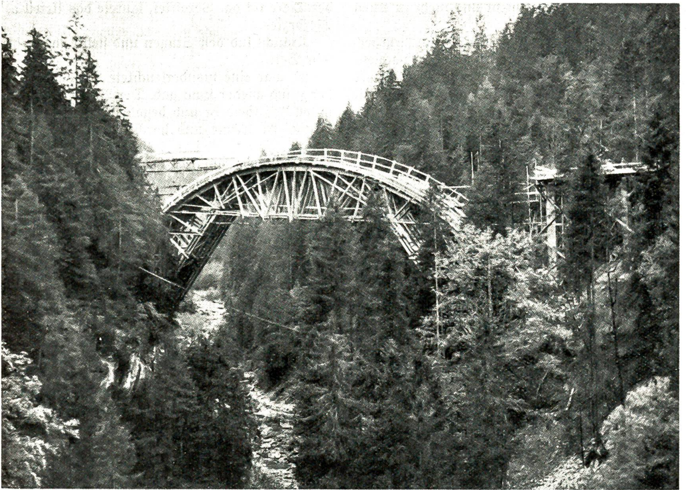
Bau einer neuen Brücke zwischen Trutigen und Adelsboden
