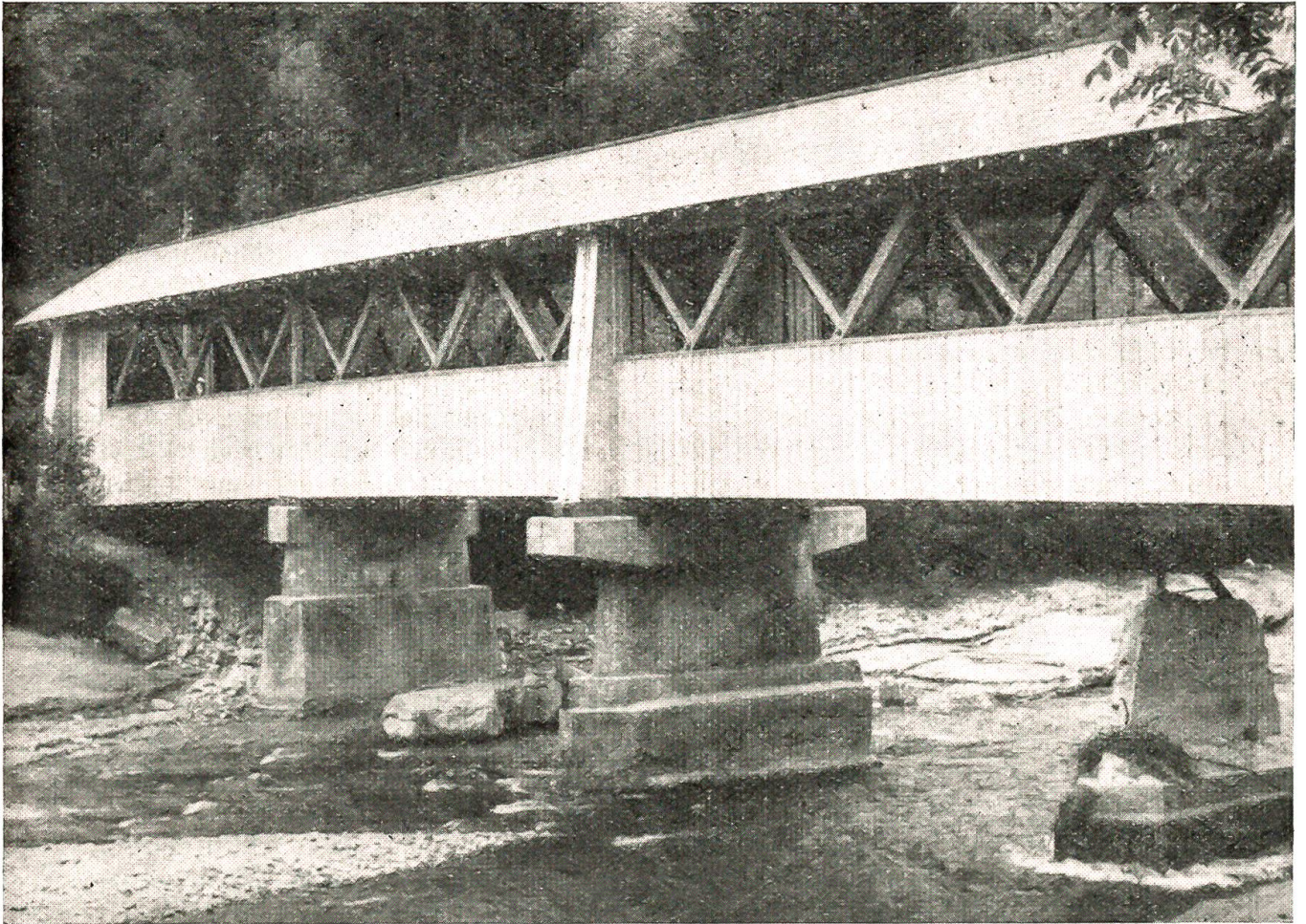
Zwischen Aberstorf und Thörishaus haben Sappeure während ihres Wiederholungskurses diese neue Sensebrücke erstellt.
