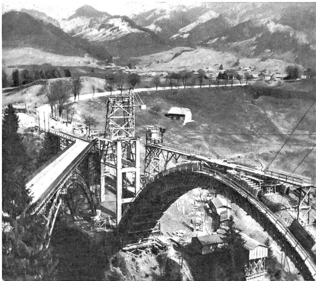
Eine neue Brücke von 160 m Länge und 9 m Breite über das Tal der Javroz im Grenerzerland
