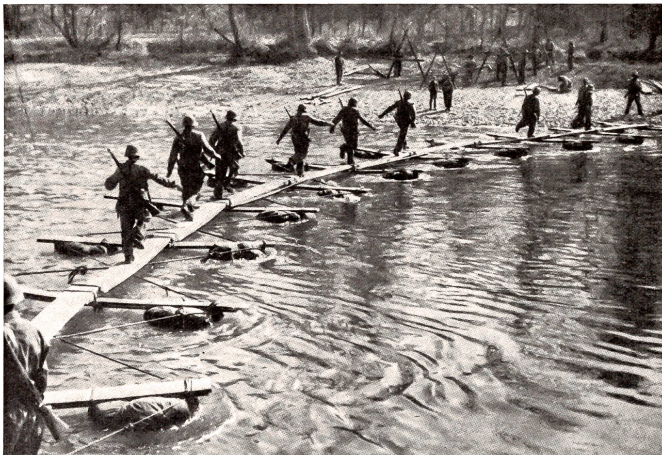
Ein schweizerisches Grenadier-Bataillon nimmt einen Flußübergang im Handstreich über einen improvisiert erbauten Steg aus Zeltbahnen mit Stroh gefüllt.
