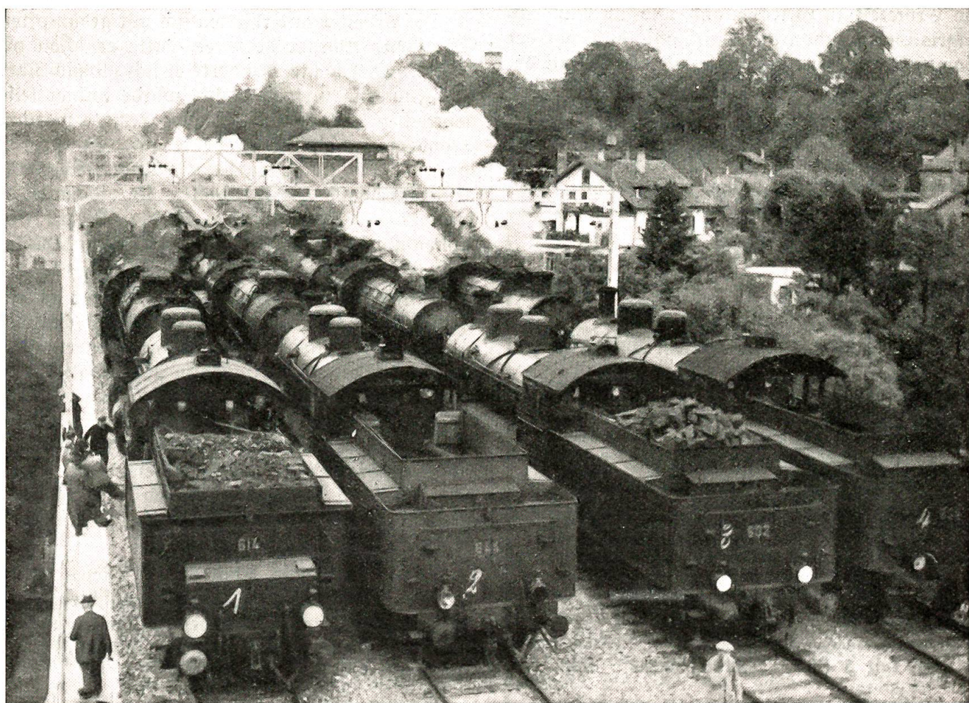
Belastungsprobe der viergleisigen Eisenbahnbrücke in Bern mit 20 Dampflokomotiven im Gesamtgewicht von 2000 Tonnen.
