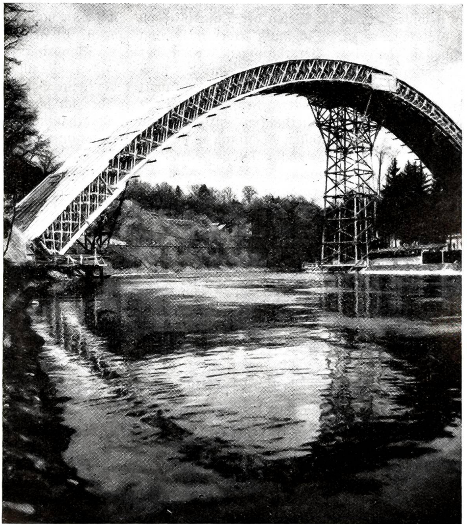
Das Lehrgerüst der neuen Eisenbahnbrücke in Bern.
