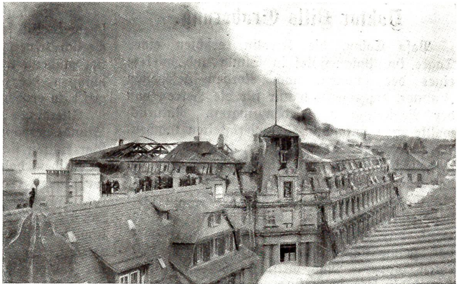
Brand des Gebäudes der Obertelegraphendirektion in Bern, 1. Mai 1932. Phot. Rohr, Bern.
