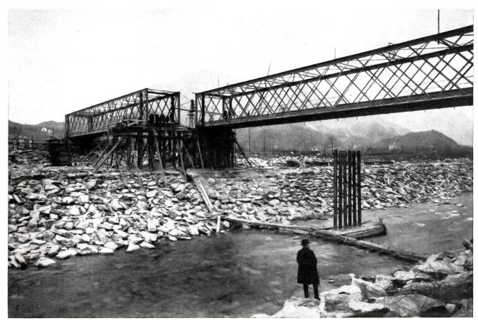
Eine interessante Brückenverschiebung bei Locarno. Phot St incmann, Vocarno. Um einer neuen Eisenbetonbrücke Platz zu machen, wurde die 100 Meter lange und 450 Tonnen schwere Maggiabrücke bei Locarno in zwei Teilen seitlich verschoben und diente dis zur Fertigstellung der neuen Brücke dem Berkehr weiter.
