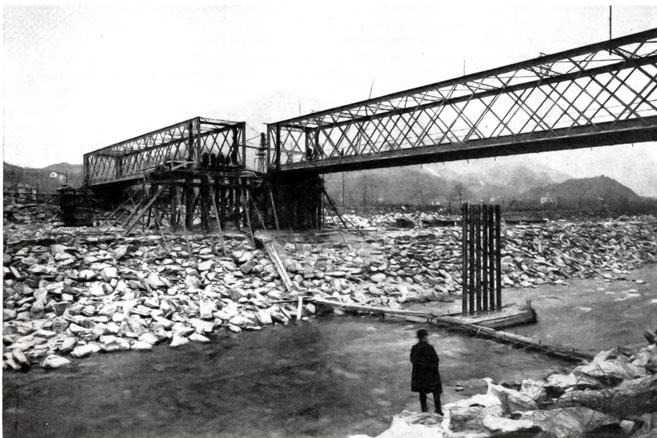
Eine interessante Brückenverschiebung bei Locarno. Phot Et inemann, Locarno. Um einer neuen Eisenbetonbrücke Platz zu machen, wurde die 100 Meter lange und 450 Tonnen schwere Maggiabrücke bei Locarno in zwei Teilen seitlich verschoben und diente bis zur Fertigstellung der neuen Brücke dem Verkehr weiter.
