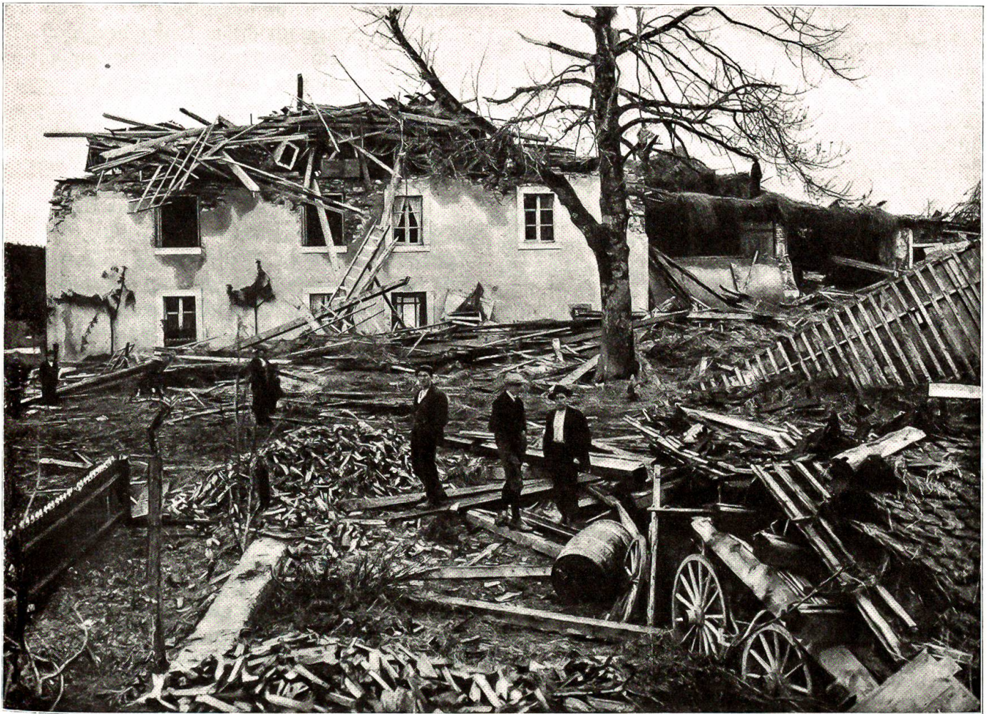
Sturmverheerungen im Jura. Zerstörtes Haus in Chaux-d'Abel.
