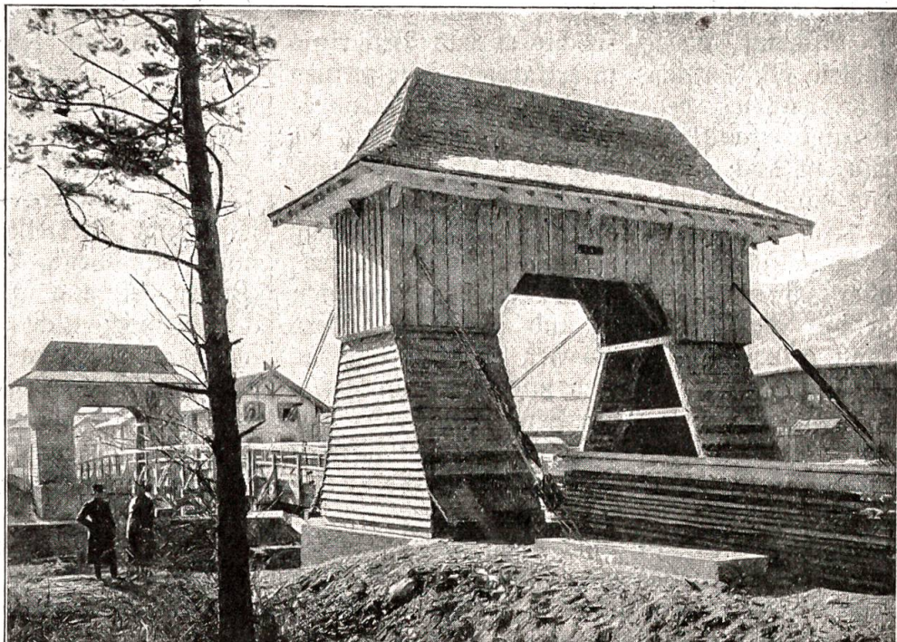
Durch Genietruppen erstellte Brücke in Landquart.
