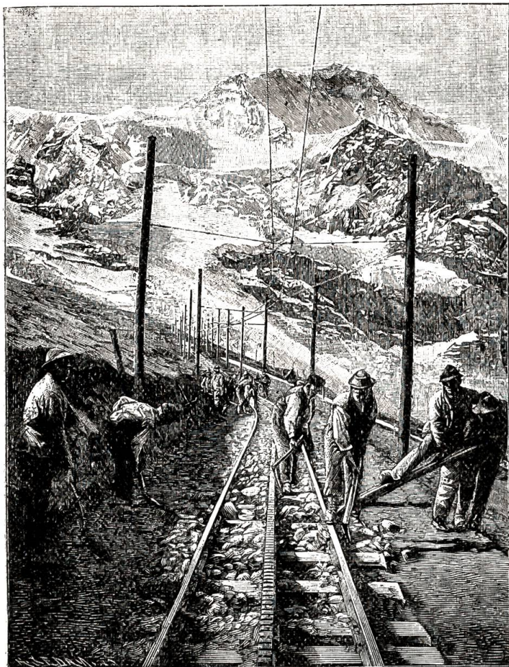
Vom Bau der Jungfraubahn: Schotterung.
