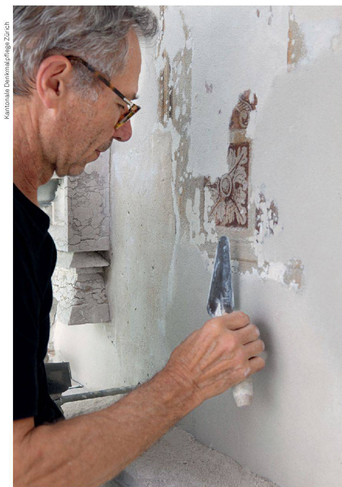
Patient travail à la truelle sur la façade principale (à gauche). La Villa Patumbah après sa restauration: à l'extrémité supérieure, la corniche du toit reconstruite avec des acrotères en tôle de zinc
