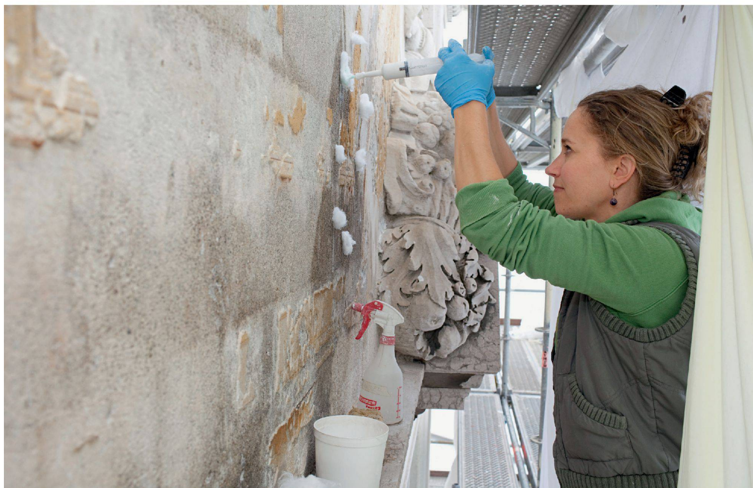
Mit fachgerechten Injektionen werden an der Aussenfassade Hohlstellen im Verputz aufgefüllt.
