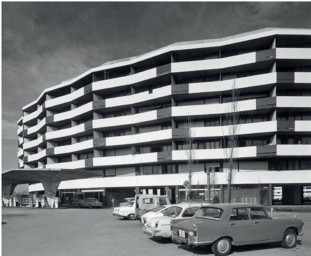
SI Surpraille, construction 1962–1964, architecte Arthur Bugna. (photo Gustave Klemm)
