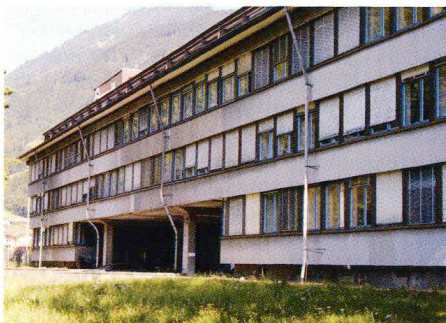
Verwaltungsgebäude Eternit AG in Niederurnen
