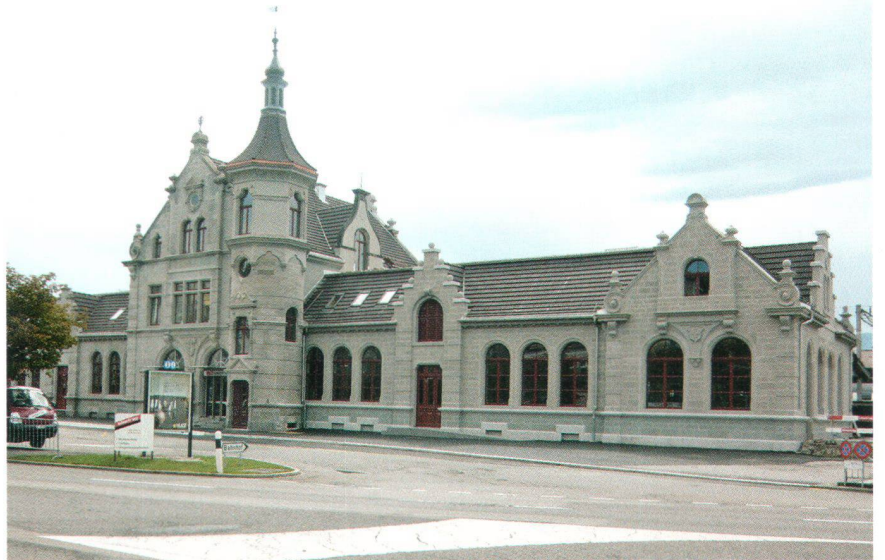
Der frisch renovierte Bahnhof Rapperswil (Bilder SHS) La gare de Rapperswil fraîchement rénovée (photos Ps)
