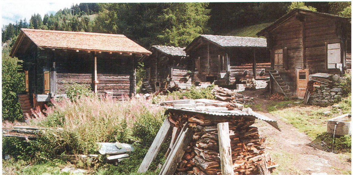
Les mayens de Rottebrigge (VS) peuvent être réutilisées grâce à des interventions minimales (photo FSPAP).
