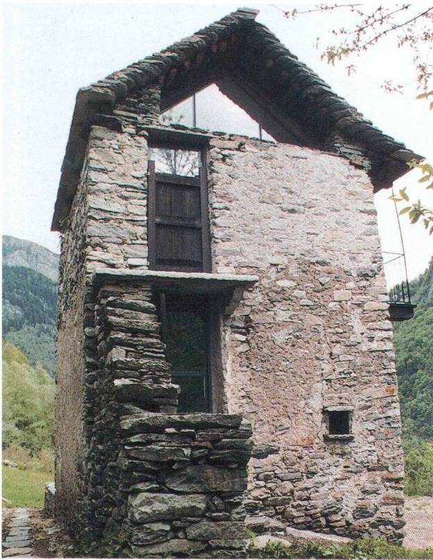
An der Casa Torre in Cà di Bazz/Cerentino TI wurden die Giebel herausgerissen und durch Glas ersetzt, um die anderen Fenster nicht ändern zu müssen. Der kleine Balkon wurde wieder vervollständigt. (Bilder SI)
