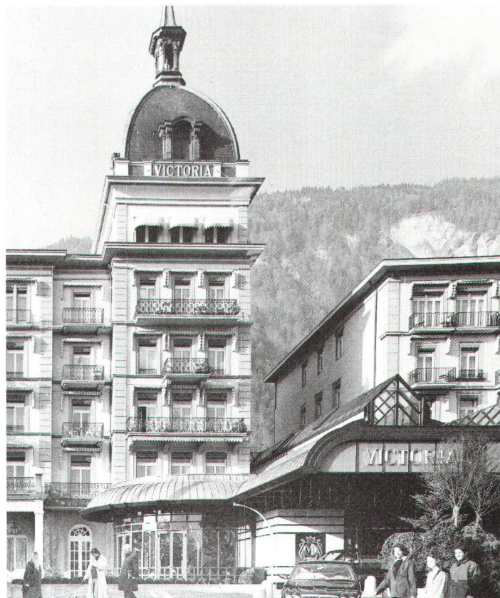
Alte Architektur mit heutigen Bedürfnissen verbunden wurden beim neuen Anbau mit Haupteingang zum Hotel «Victoria-Jungfrau». (Bild Stähli)
