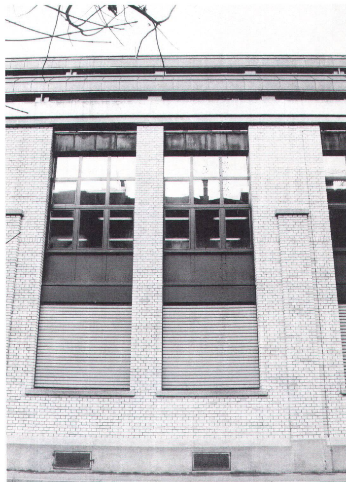
Dem baulichen Detail wird die gleiche Aufmerksamkeit zuteil wie der planerischen Arbeit (Bild Kurtz).
