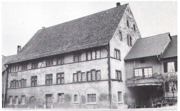
Mit der Stiftung des Aargauer Heimatschutzes soll das Säckinger Amtshaus gerettet und renoviert werden (Foto Heimatschutz).
