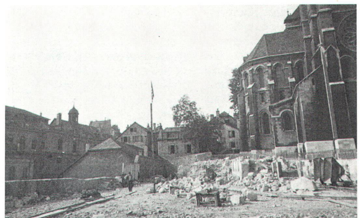
En 1940, un tiers de la vieille ville devait être démoli (photo d'archive).
