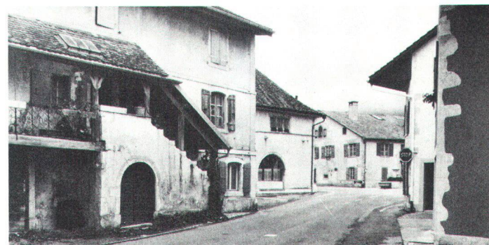
... mais il y aura encore beaucoup à faire pour maintenir la substance architecturale de Môtiers (photo Stähli). ... aber es gibt noch viel zu tun, um in Môtiers die historische Bausubstanz zu erhalten (Bild Stähli).
