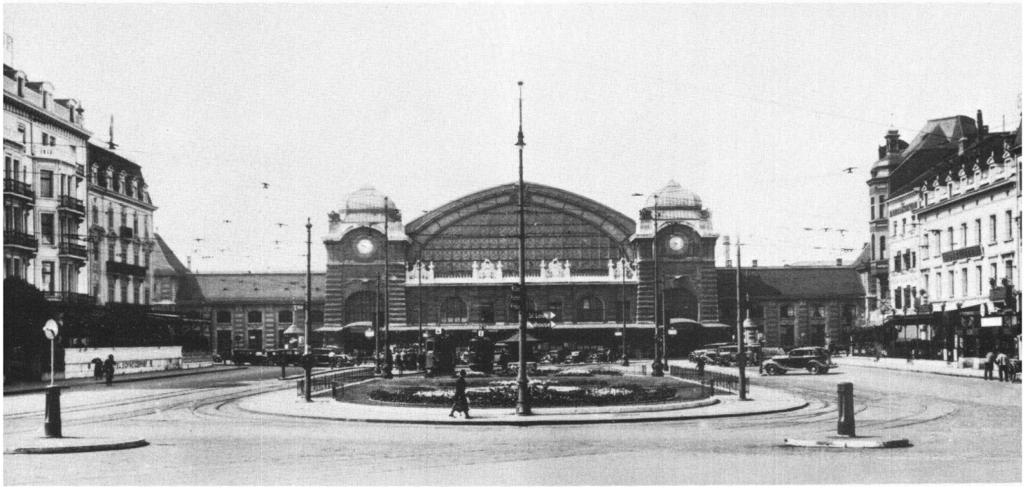
Der Bahnhof Basel SBB, mit mächtigem Portalbogen in Glas-Eisen-Konstruktion, wurde 1907 nach Plänen von Emil Faesch (1865–1915) und Emanuel La Roche (1863–1922) vollendet.
