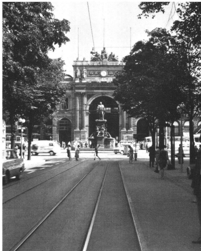
Den optischen Abschluss der Zürcher Bahnhofstrasse bildet der als Triumphtor der Technik ausgestaltete Eingang des Hauptbahnhofes. Das Gebäude entstand 1865–1871 nach Plänen von Jakob Friedrich Wanner (1830–1903).
