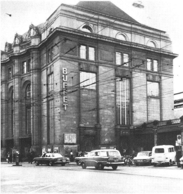
Der 1911–1913 von Alexander von Senger (1880–1968) mit barocken Detailformen erbaute Hauptbahnhof St. Gallen ersetzt den Bau von 1856.
