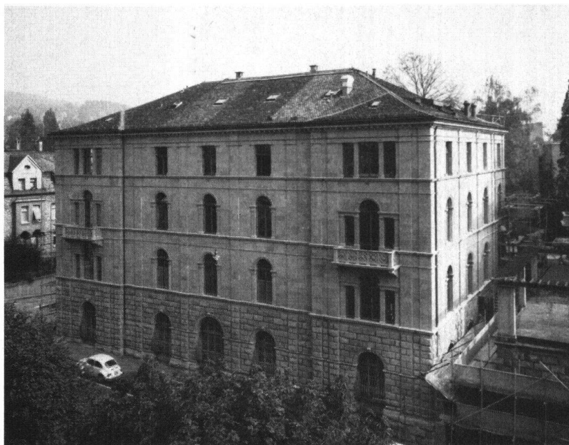
Zürich-Fluntern. Haus «Zum Sonnenbühl» Zürichbergstrasse 8. Nach der Restaurierung 1973/74
