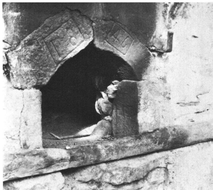
Oben: Das Feuer im alten Backofen von Les Arlaches wird nicht erlöschen.
