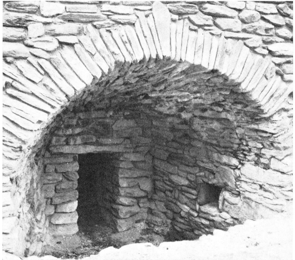
Voûte d'accès et tuyère (ouverture pratiquée à la base d'un four pour le passage de l'air soufflé).
