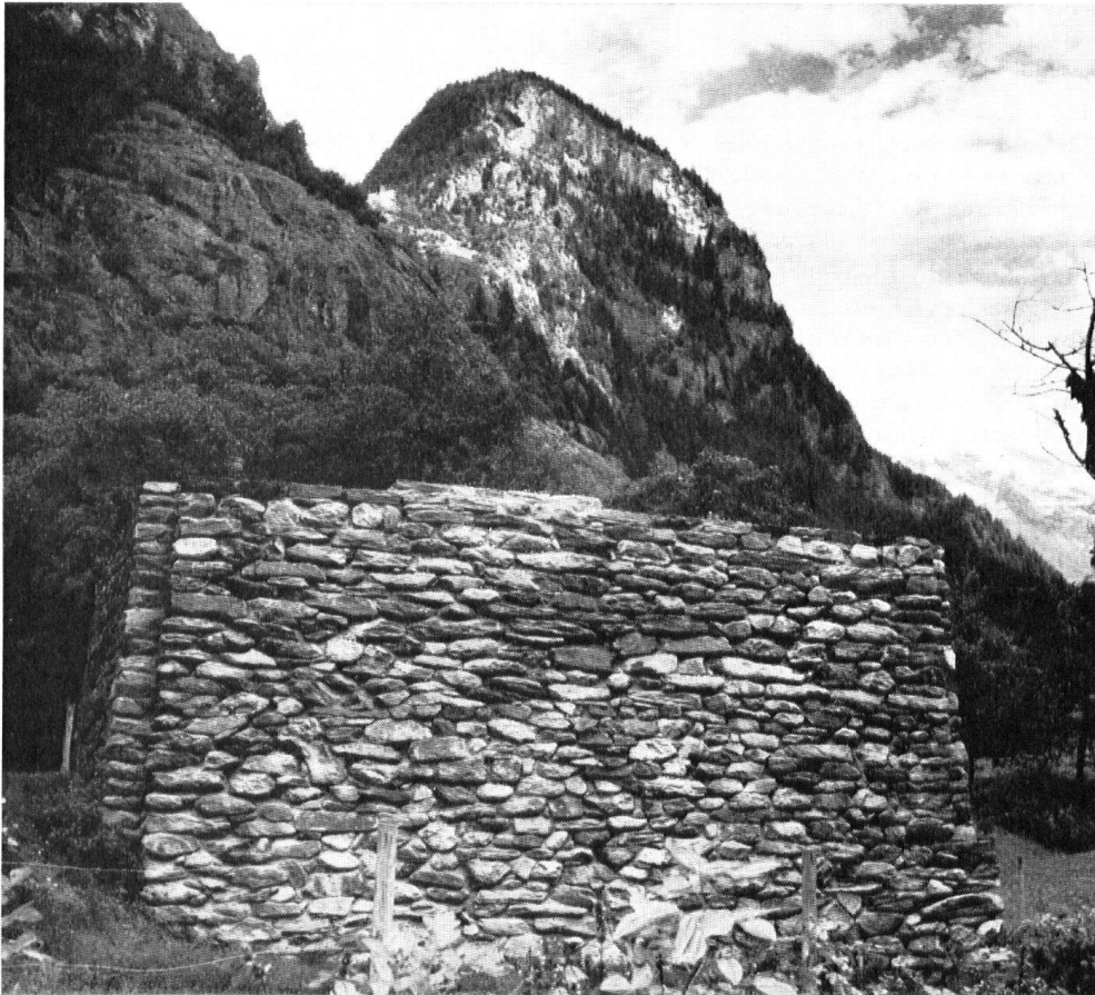
Un autre aspect du four à métaux reconstruit.
