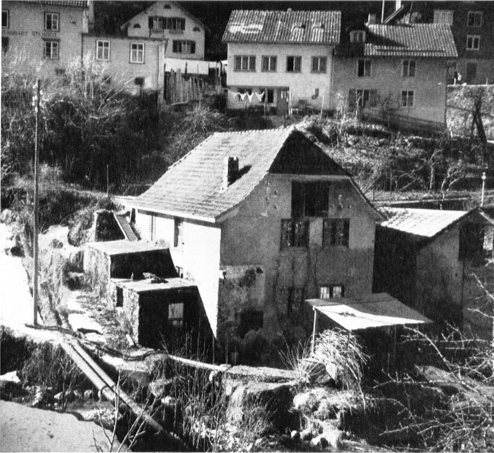
Telle était la forge... Restauration exécutée avec l'aide de la section glaronaise et de la Ligue suisse.
