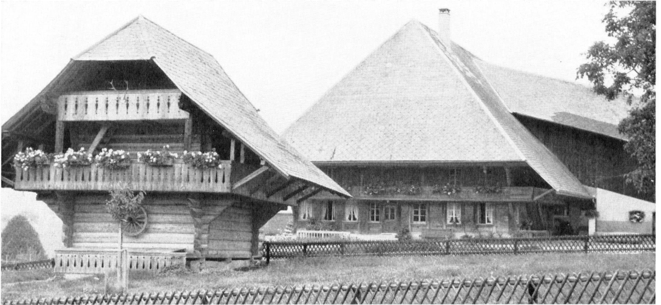
Erneuerter alter Bernerhof mit neuem Stallteil. Der Speicher wurde verschoben und wird pietätvoll erhalten. Das Dorfbild ist gewahrt.
