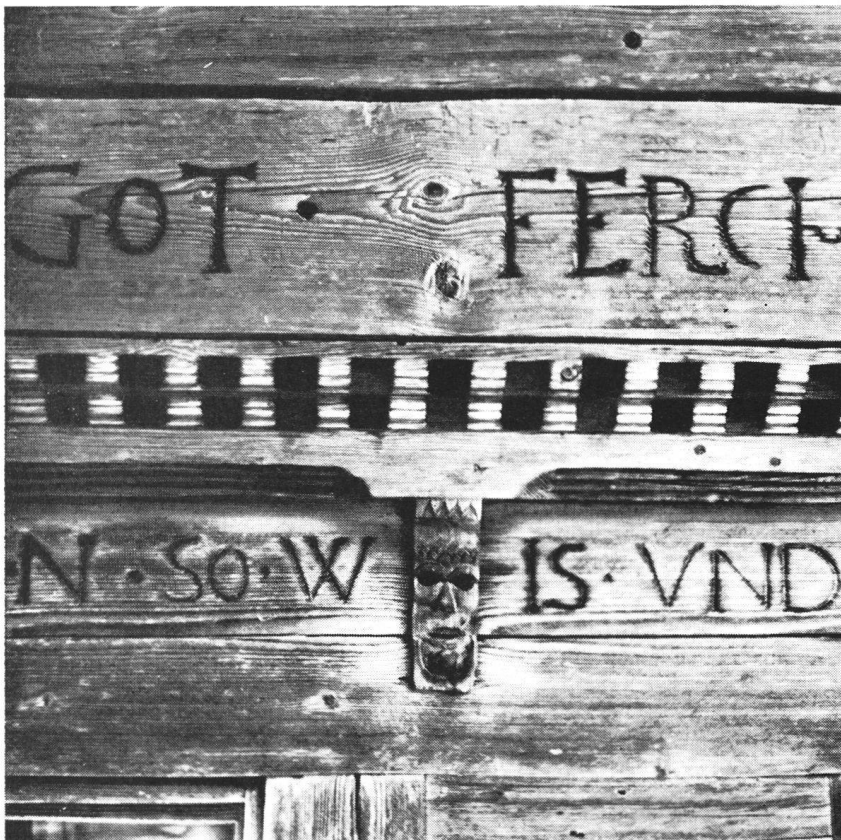
Die durch den Zimmermann vielfältig abgewandelten Überkragkonsolen am Haus Reinhart.
