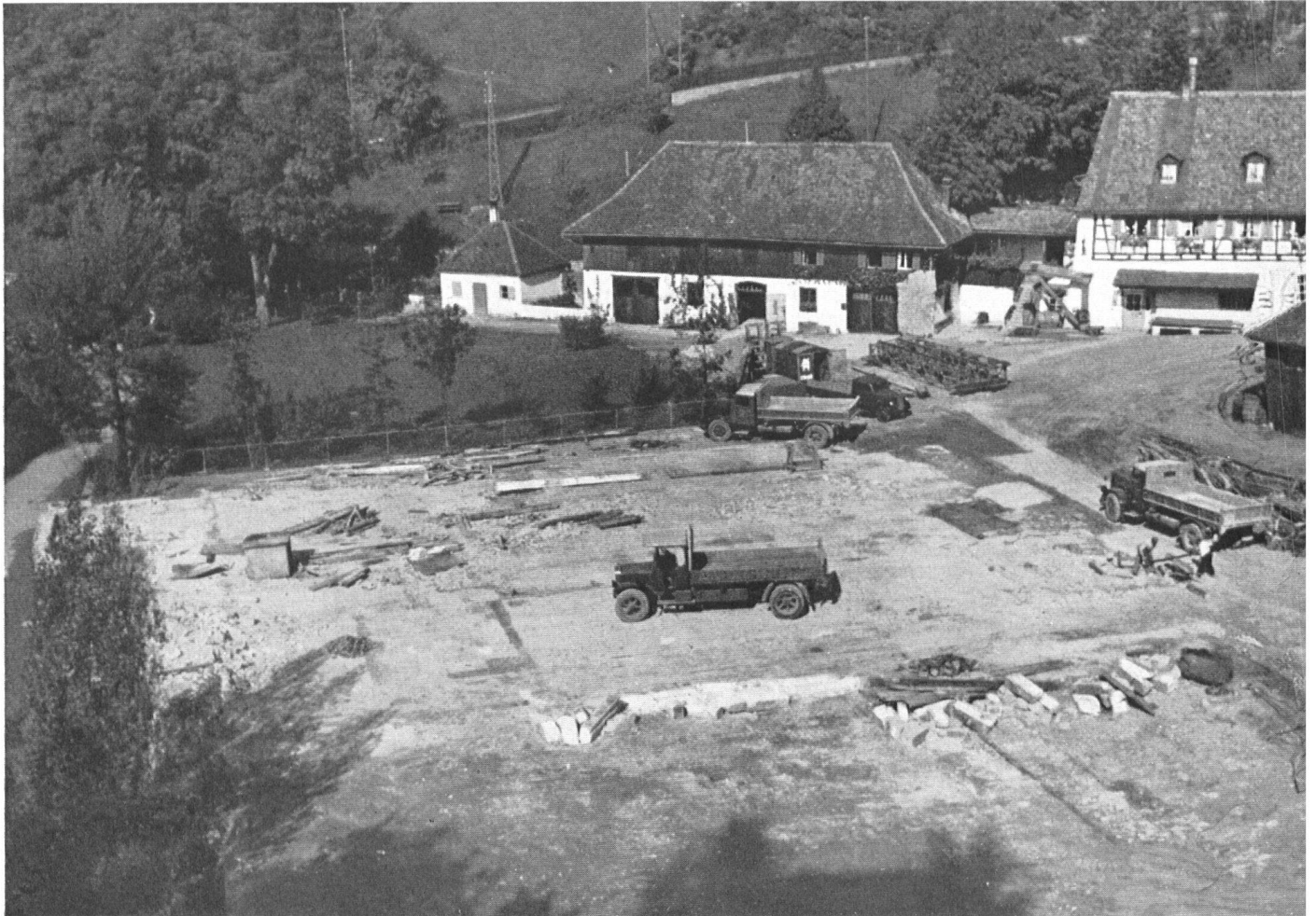
Les bâtiments industriels sont maintenant rasés. Le
