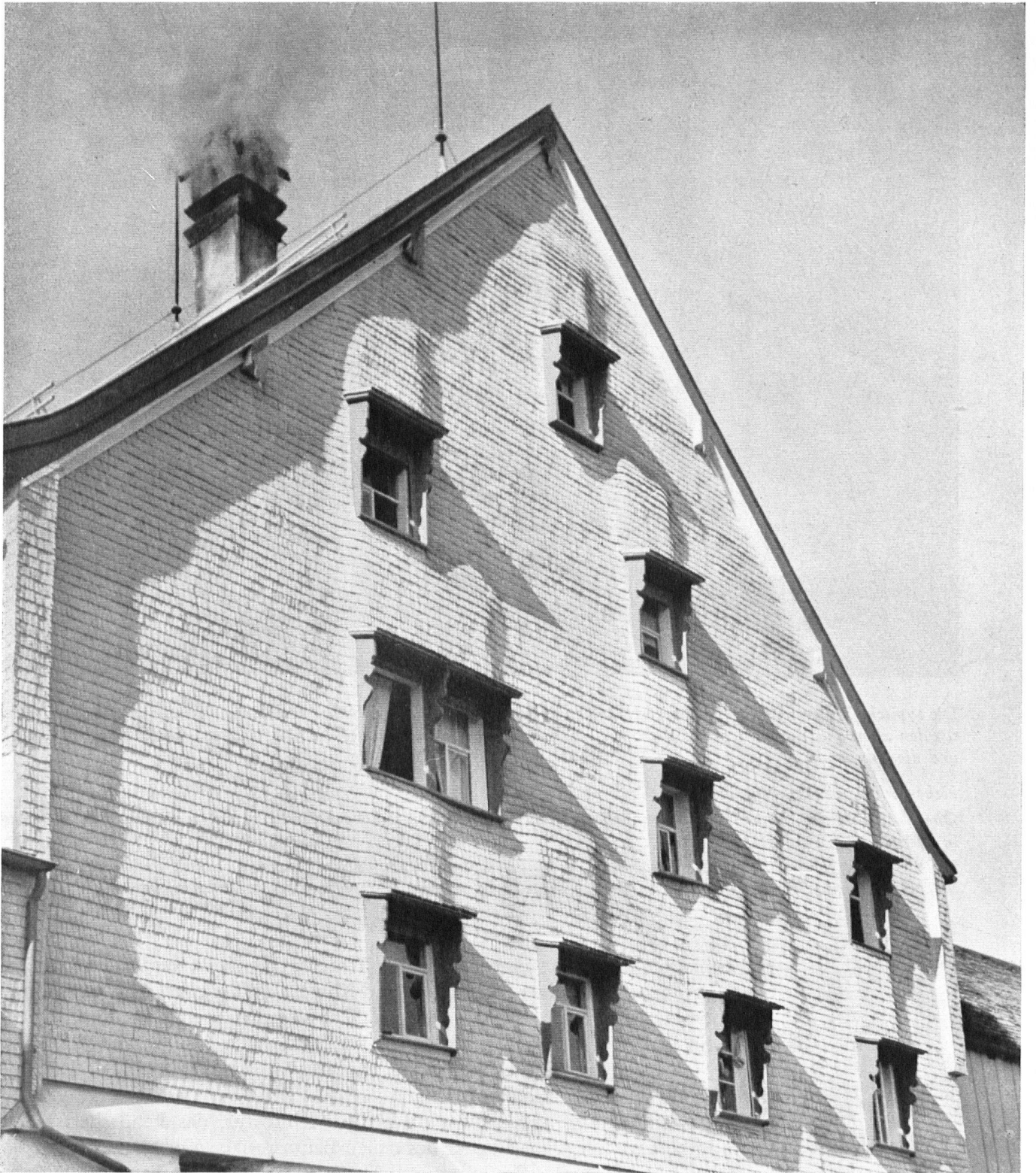
Die folgenden Bilder zeigen verschiedene Arten von Wandverkleidungen. Hier ein Appenzeller Haus mit seinem prächtigen, hellgestrichenen Schindelmantel.
