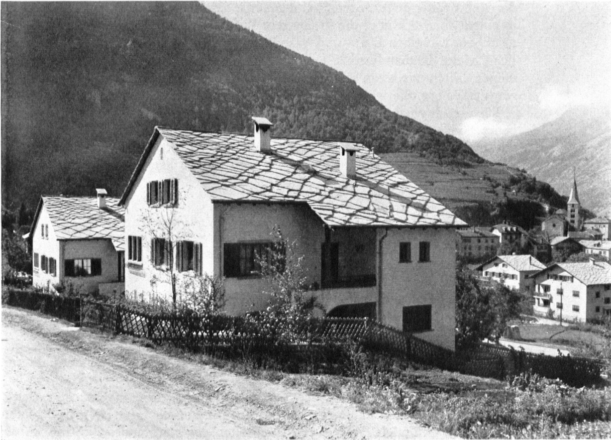
Im Wallis verwendet man Schieferplatten, die sich verhältnismäßig dünn und großflächig brechen lassen. Unser Bild zeigt die Verwendung dieses vorzüglichen Bedachungsmaterials an neuen Bauten für die Angestellten eines Industrieunternehmens in Visp.
