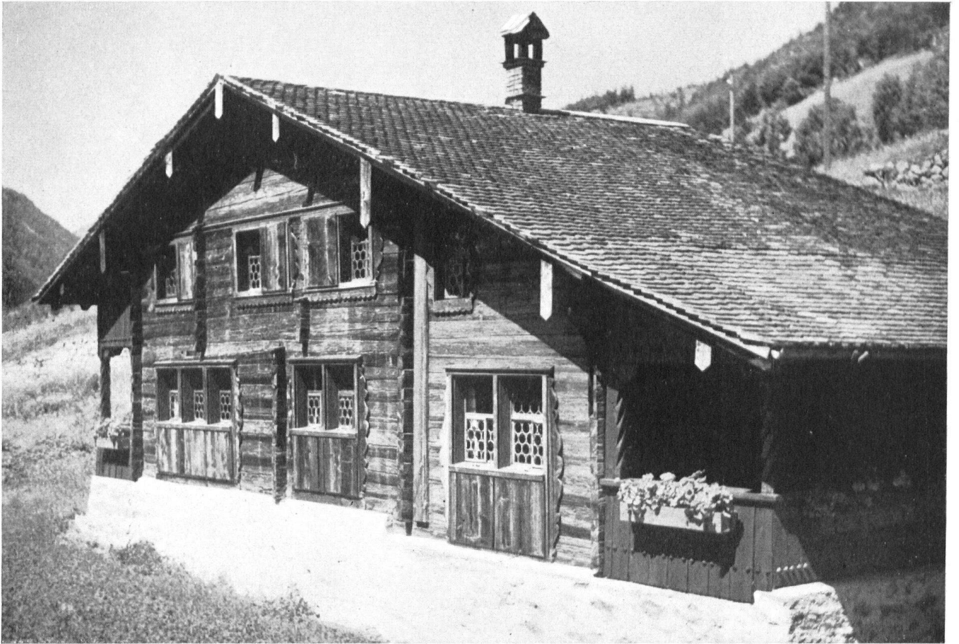
Das sog. »Kalcherli« in Seelisberg, das älteste Haus der Gegend, heute unter Leitung der Bauberatungsstelle des Heimatschutzes und mit einem Beitrag der Sektion Innerschweiz stilvoll erneuert. Die beiden Wohnungen werden an Feriengäste vermietet.
